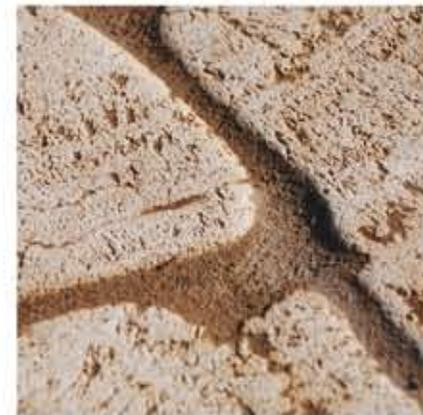
le stesse guideranno anche la conformazione e lo spessore degli spazi di giunzione fra le scaglie di travertino. La fase di stuccatura dei giunti è realizzata utilizzando boiaccia di cemento e sabbia che può essere unita a polvere di marmo ed eventualmente colorata. Le nostre varietà cromatiche (chiaro, scuro e rosato) consentono inoltre di ottenere numerose soluzioni compositive, comunque sempre diverse e personalizzabili anche attraverso la realizzazione di disegni e geometrie particolari.
